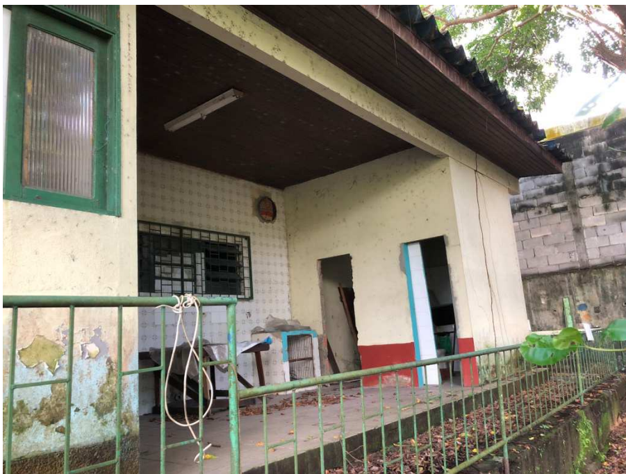
FIG. 14 - PARTE DE TRÁS DO PRÉDIO
