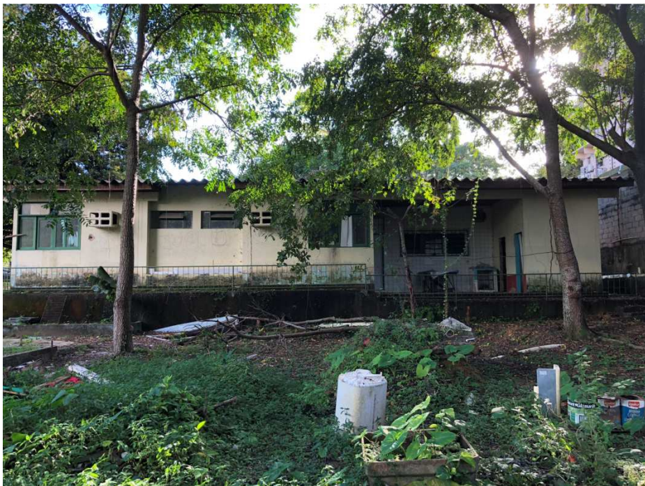
FIGURA 12 – PARTE DE TRÁS DO,PRÉDIO
