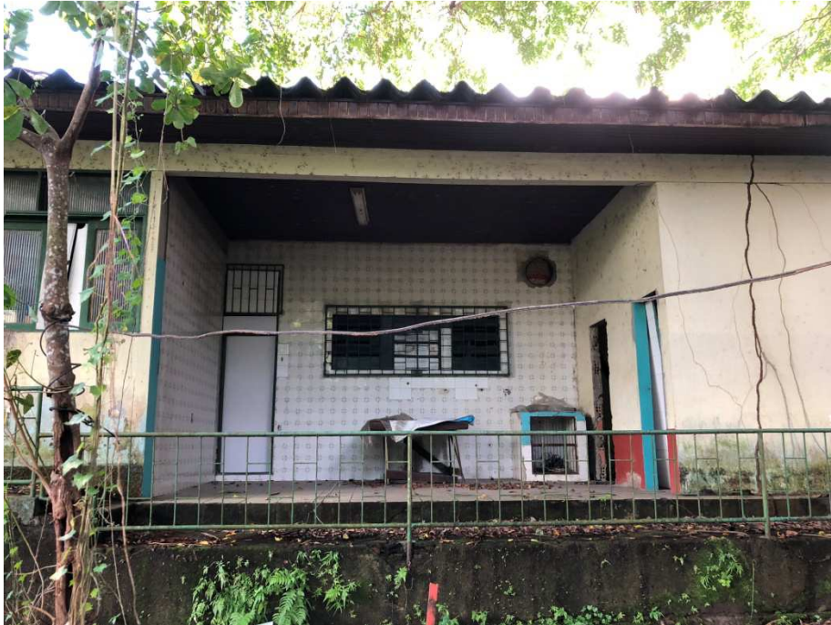
FIG. 13 - PARTE DE TRÁS DO PRÉDIO
