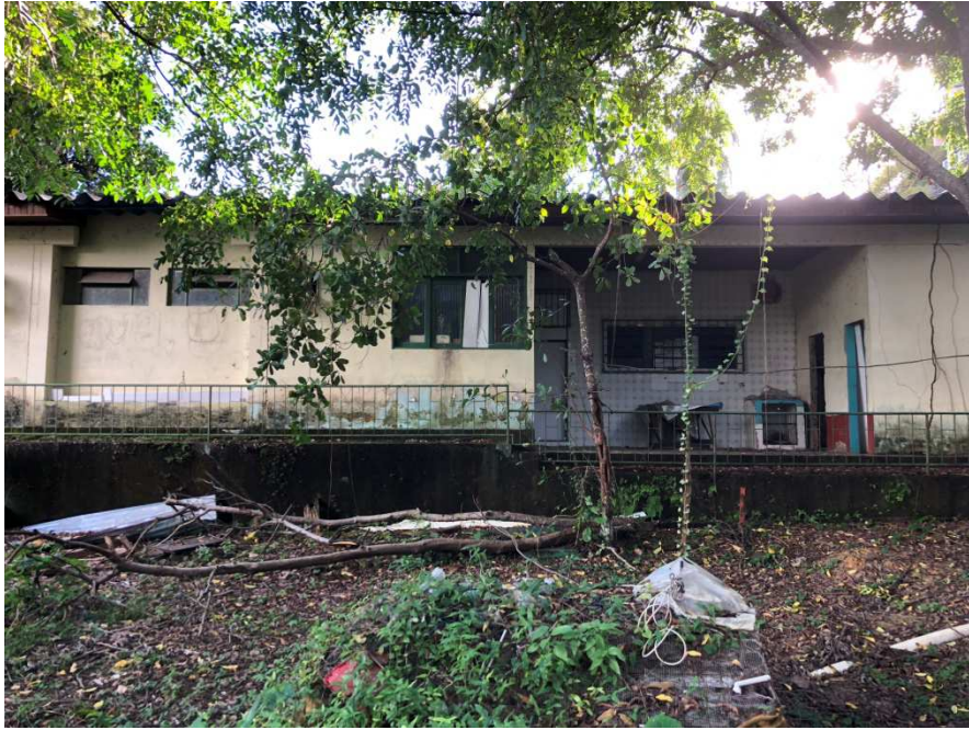
FIG.11 – PARTE DE TRÁS DO PRÉDIO
